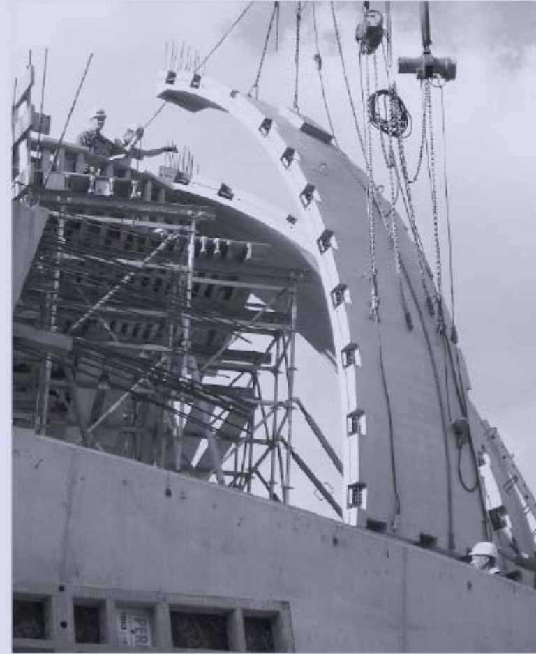
13 | 14 Montage der Stahlbetonkuppel aus Fertigteilstegmenen — Assembly of the reinfor- ced concrete dome from precast elements
