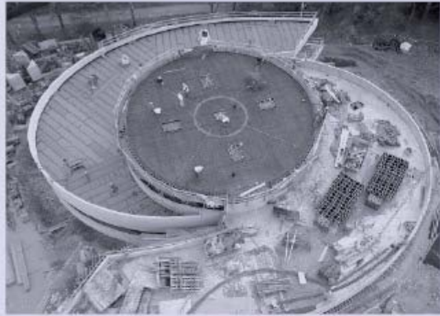
24 Nach Abschluss der Fertigteilmontage war die Kuppel statisch selbsttragend — After completion of the assembly of precast elements the dome was structurally self-supporting
