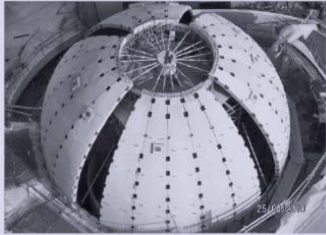
19 | 20 Montage der Fertigteil-segmente — Assembly of the reinforced concrete dome
